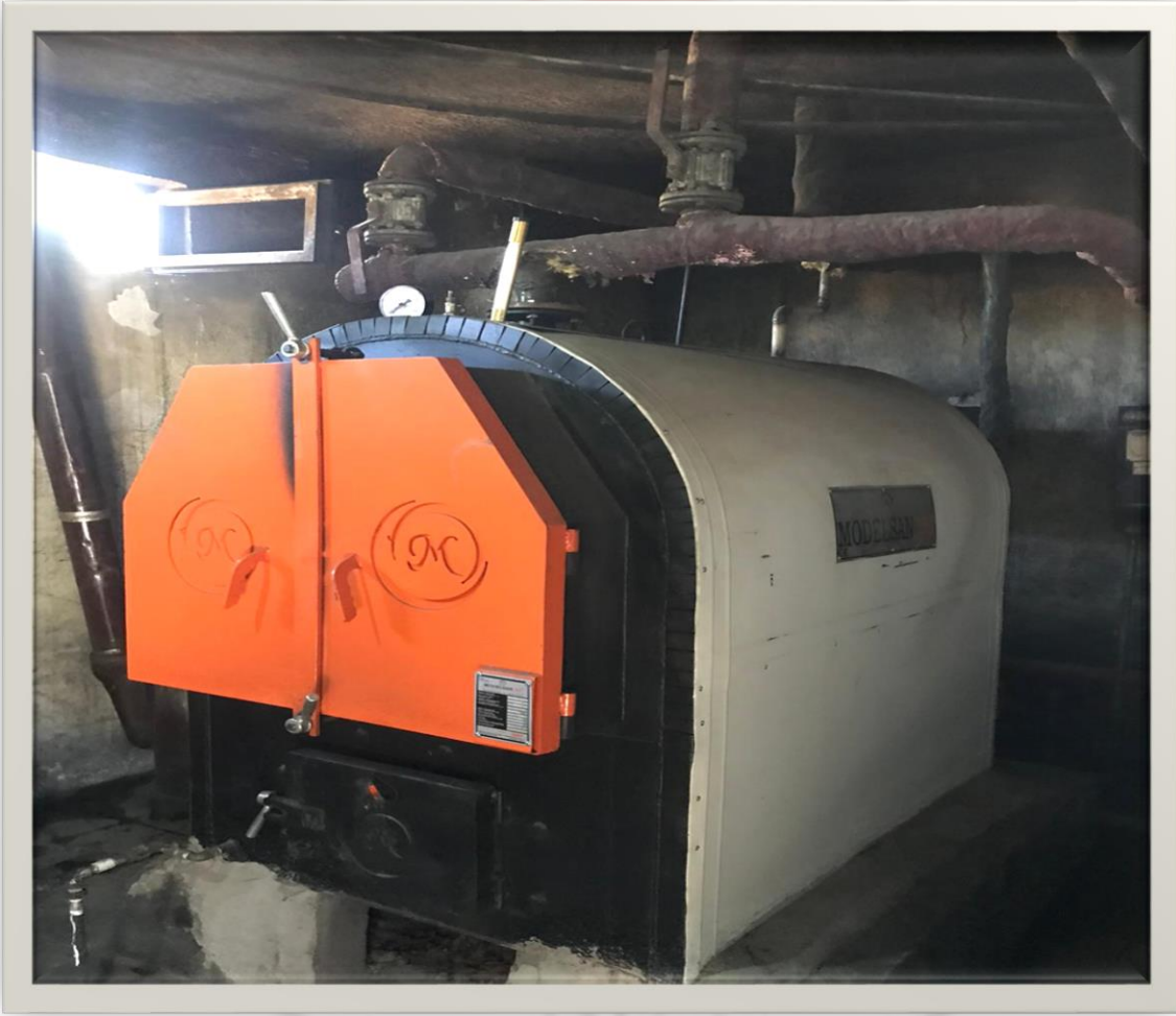
Mutki İlçe J.K.lığına bağlı Cevizyatağı J.Krk.K.lığı Kalerifer Kazanı Değişim İşi
