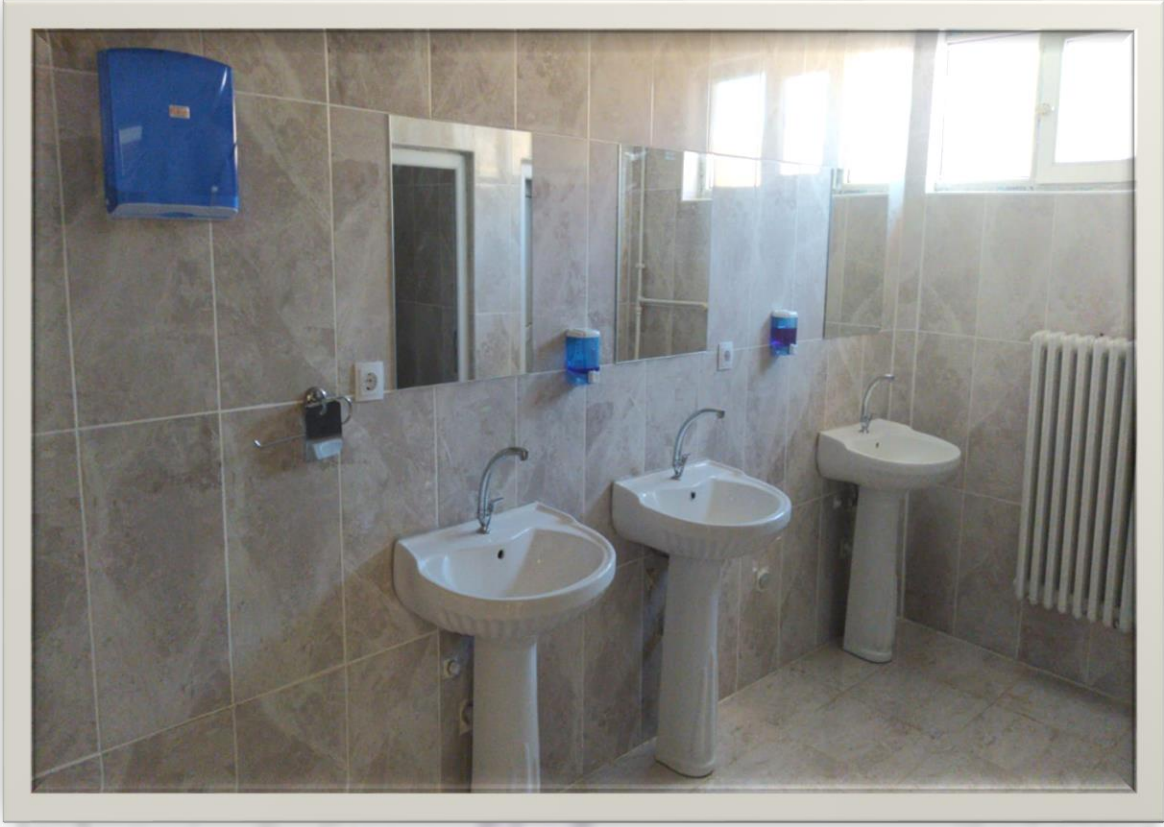
Hizan J.Komd.Tb.K.İğı Hizmet Binası Bakım Onarım İŖi
