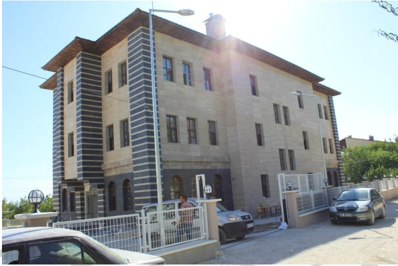
Resim 3- Adilcevaz İlçe Emniyet Müdürlüğü Binası
